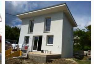
Der Dachvorsprung wurde verputzt - keine Holzflächen
