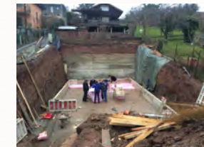
Kelleraushub mit Sauberkeitsschicht und Hangsicherung
