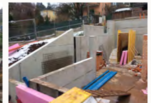
Kellerwände mit Stiegeschalung und NF-Pfeiler
