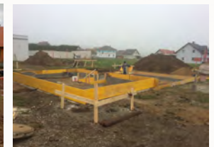
abschalen der Fundamentplatte mit Schnurgerüst
