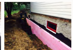
flämmen oder spachteln der Kellerwände mit Bitumen
