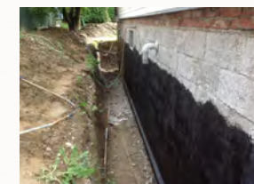
freilegen der Kellerwände und Voranstrich herstellen
