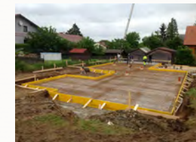
ingeschalte Fundamentplatte vor dem Betonieren
